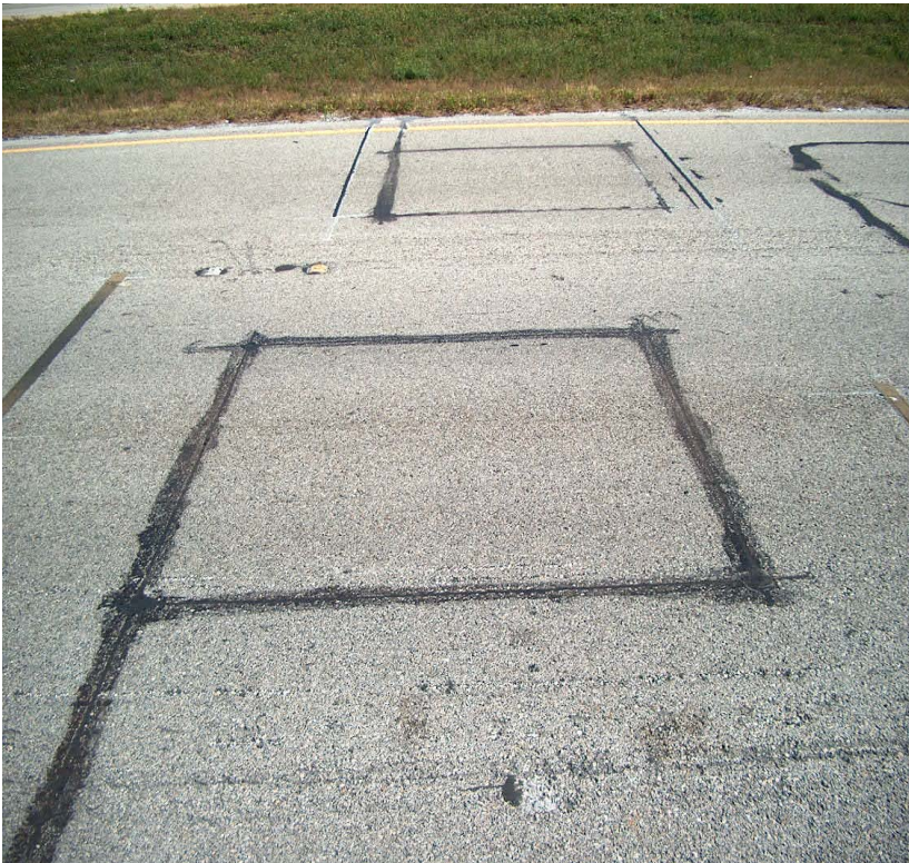
Loop_Sensor_TO_2_12_12A_0100_12_03_03.JPG
